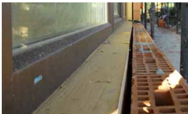
Particolare del sormonto del telaio con il secondo strato di isolante.
