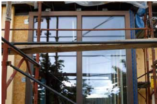
Posa del serramento sulla struttura lignea del padiglione.
