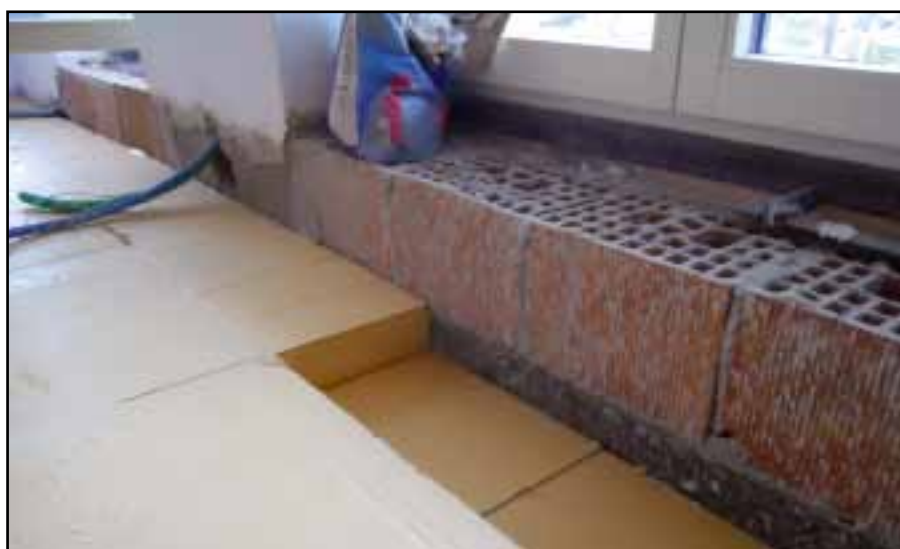
Particolare esecutivo del solaio
