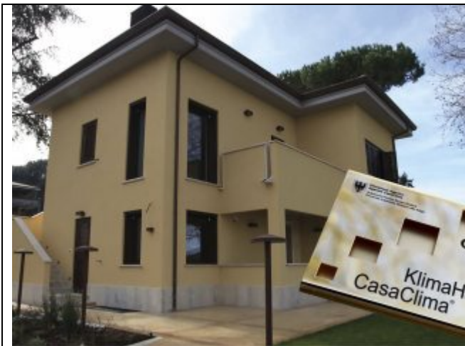
Esterno Villino Brenca ad Anguillara Sabazia (RM)
