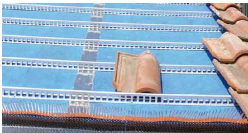
curi l'assenza di punti di ostruzione o riduzione dello strato di ventilazione e l'agevole ingresso e fuoriuscita dell'aria senza pregiudicare la tenuta all'acqua del manto.
