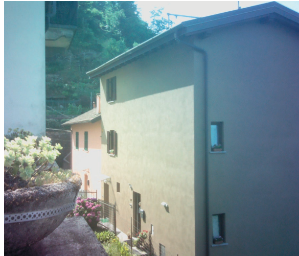
Mansarda senza impianto di raffrescamento - Bellano
