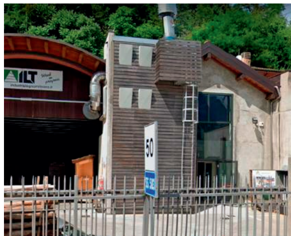
Ufficio con impianto di raffrescamento - Galbiate
