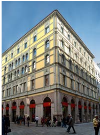
Palazzo Ricordi, Milano LEED® Gold STIFERITE RP1
