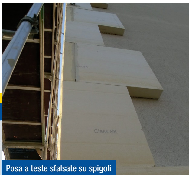
Soluzione mista cappotto e facciata ventilata (STIFERITE Class SK e Fire B)
