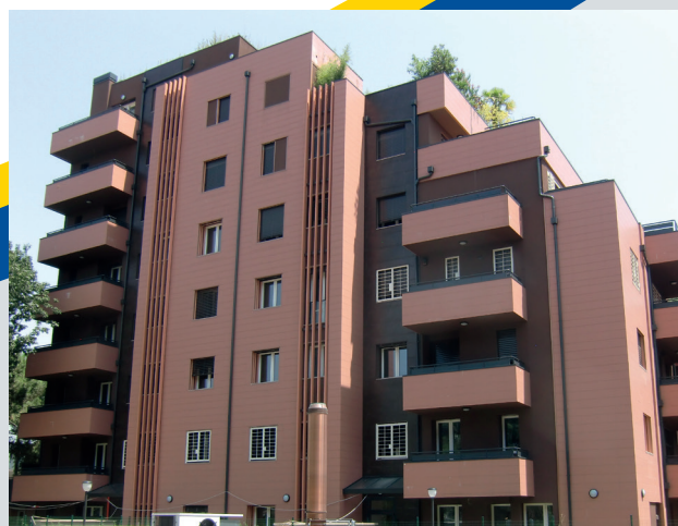
Soluzione mista cappotto e facciata ventilata (STIFERITE Class SK e Fire B)
